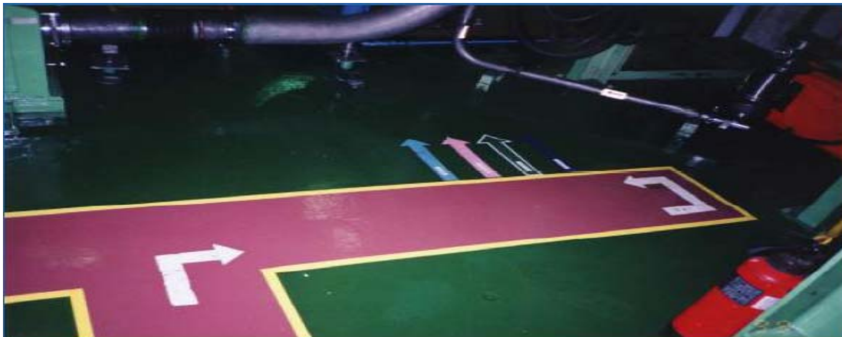
发电机房的点检路线箭头标识及干净明确的地面区域规划线
